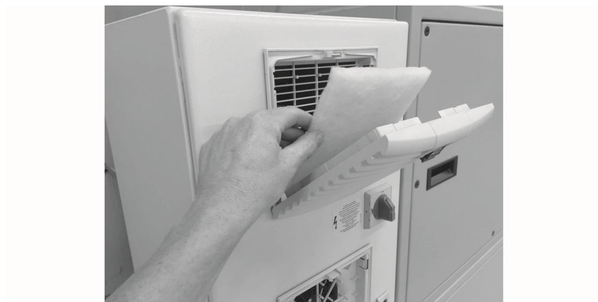
Rys. 39: Wymiana filtra szafy sterowniczej
